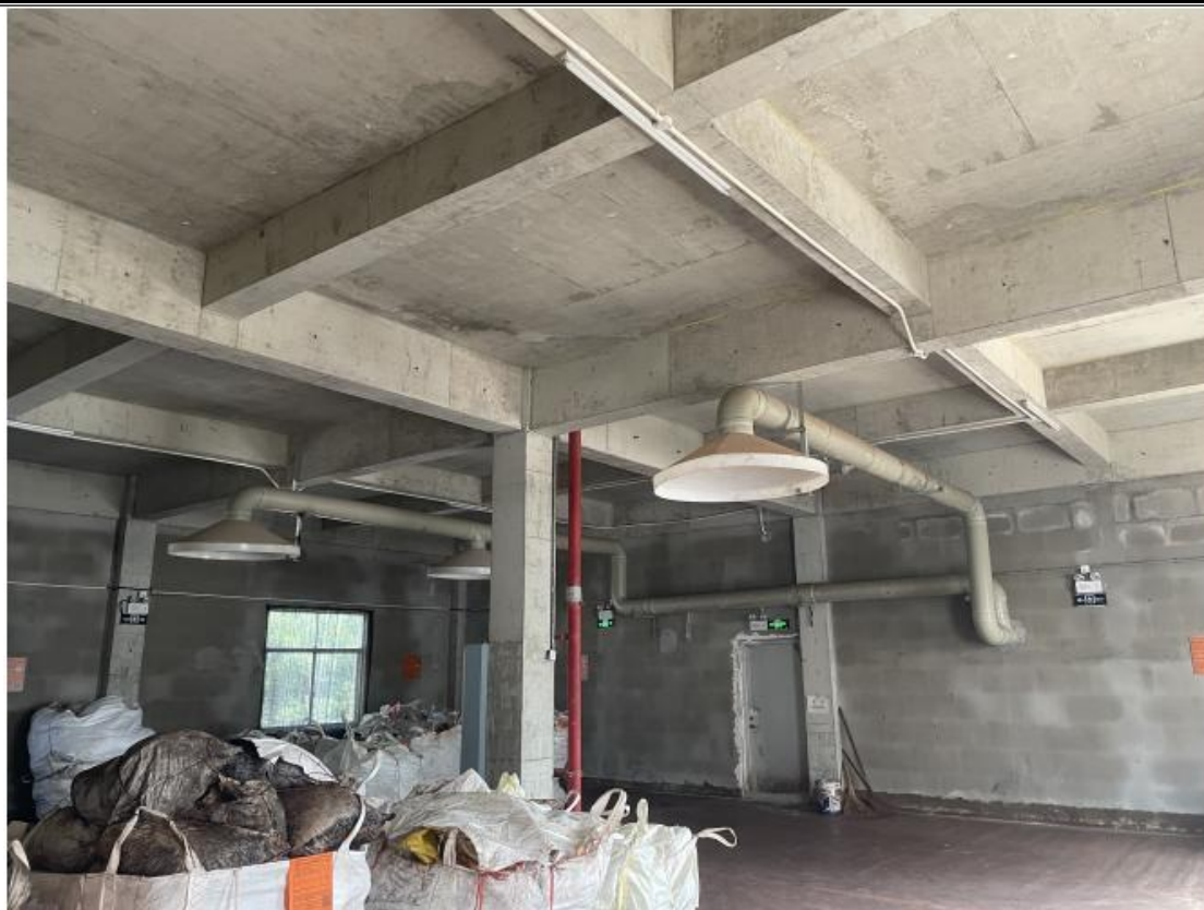
危险废物暂存间内部分类收集
