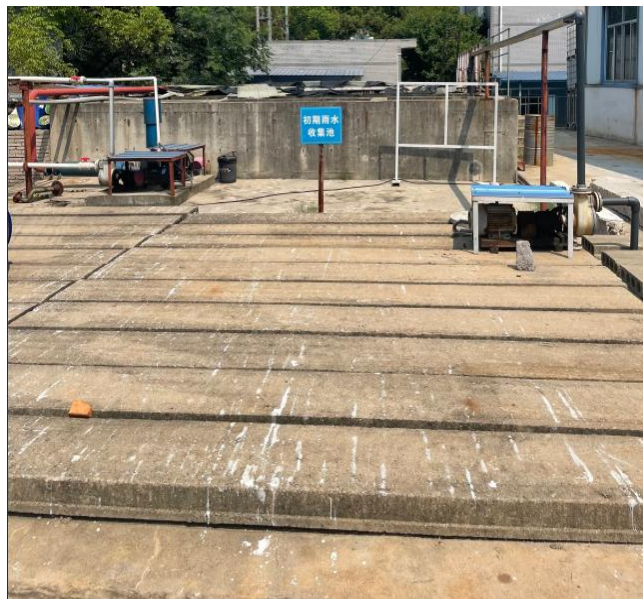
初期雨水收集池
