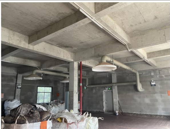
危废间内部防渗
