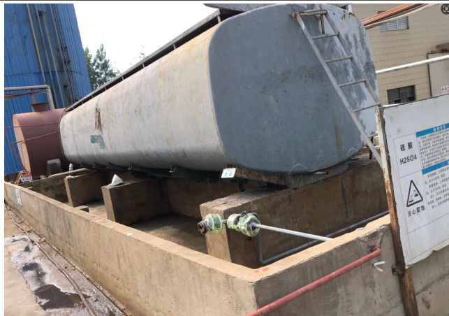
原料罐区围堰
